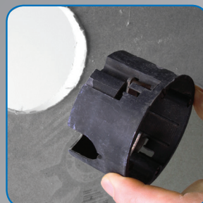
5. EINPASSEN DER SCHALTERDOSE
